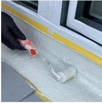
Repasser une nouvelle couche de Sikalastic®-625 N sur les fibres qui dépassent, les trous ou les zones exposées.
