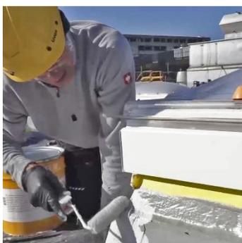
Appliquer la 1re couche de Sikalastic®-625 N avec au min. 1.0 l/m<sup>2</sup> (1.25 kg).
