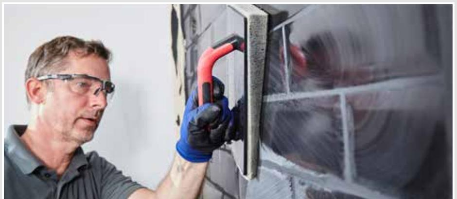
Wenn die Fuge eingebracht ist, den Zeitpunkt des Waschens über den Fingerdrucktest ermitteln. Erst wenn der Fugenmörtel in der Fugen ausreichend angezogen hat, wird der Belag abgewaschen.
