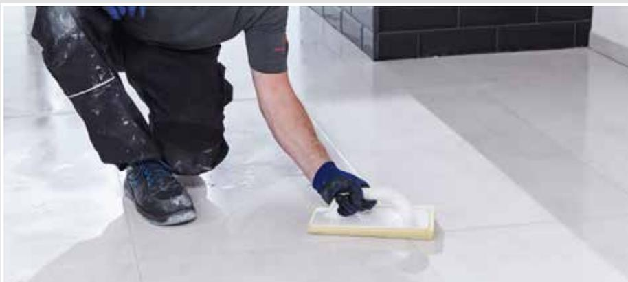
Falls nach dem Waschen noch leichte Fugenschleier vorhanden sind, werden diese mit wenig, aber sauberem Wasser, einem Schwammbrett oder auch einem Mikrofasertuch entfernt. So wird Wasser im Überschuss auf den Fugen vermieden.
