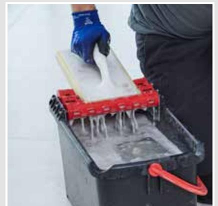
Der Einsatz einer Waschbox erleichtert die Reinigung des Schwammbretts und damit das Reinigen der Fläche.
