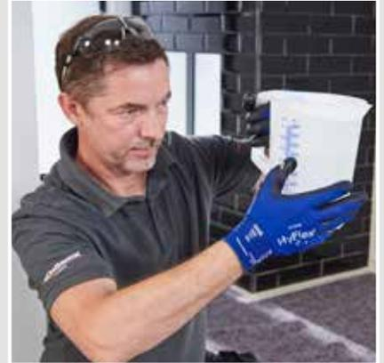
Die passende Wassermenge abmessen. Das 5,0 kg Gebinde mit ca. 1,4 l - 1,45 l Wasser anrühren.
