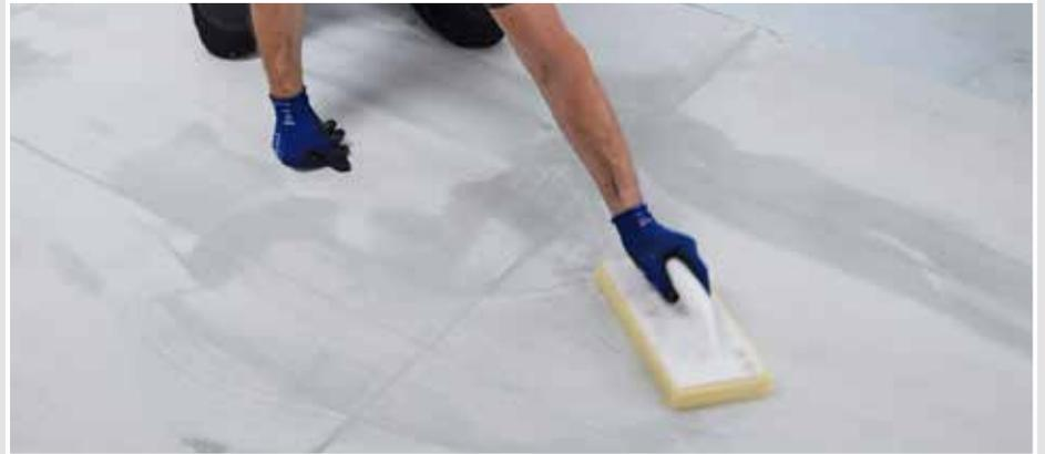
Um das angezogene Material einfach von der Fliesenoberfläche zu entfernen, ohne die Fuge bereits zu tief auszuwaschen, ist der Belag mit wenig Wasser zu befeuchten. Dieses kann ggf. auch sehr gut mit einer Sprühflasche erfolgen. Anschliessend das Wasser einwirken lassen.
