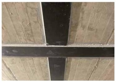
Un système de protection rigide et perméable à la vapeur d'eau conforme à la norme OS 8 a été appliqué sur le radier. Il se compose de deux couches de Sikafloor®-161, résine époxy avec sable de quartz et d'une couche de finition époxy type Sikafloor®-378. Pour le renforcement structurel, 6 000 m' de lamelles en fibres de carbone Sika® CarboDur® M914 ont été posées et collées avec l'adhésif à base de résine époxy Sikadur®-30 Normal.
