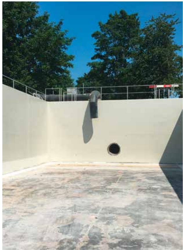
Anschließend wurden fast 4 000 m<sup>2</sup> Fläche mit dem flexibilisierten Epoxidharz Sikafloor®-390 N überzogen und versiegelt.
