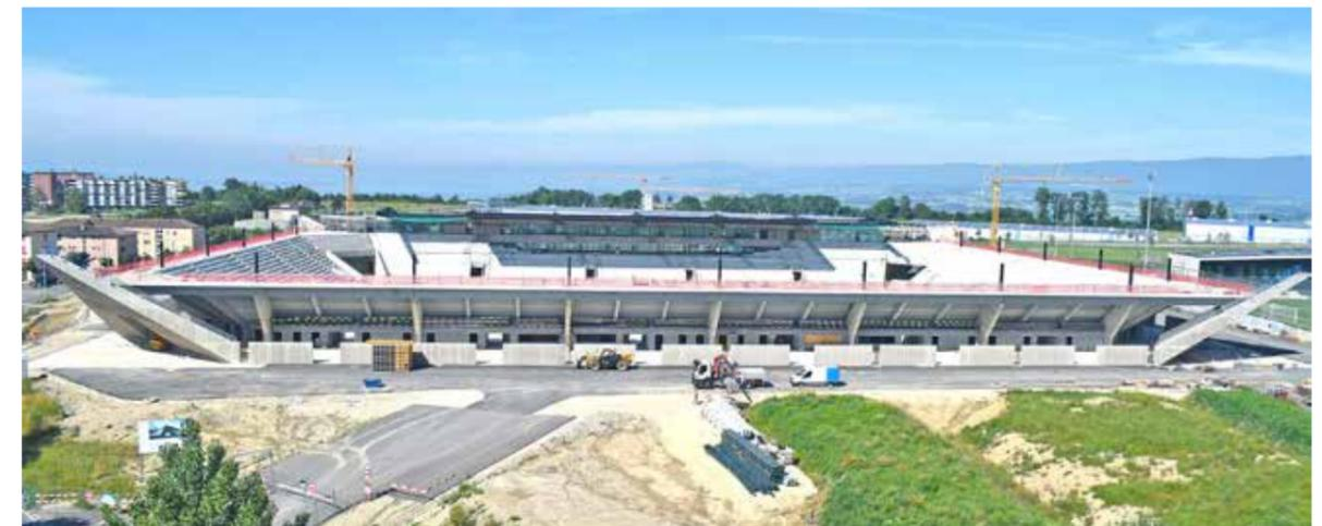
SA in Bulle schon eine Tribüne ausgeführt. Ein halbes Jahr später wurde im Werk die zweite Etappe beschichtet und gespritzt. Die Montage war für Mitte Oktober vorgesehen. Die werkseitige Beschichtung wurde bewusst gewählt, um eine möglichst lange Schutzdauer und Wirksamkeit des Beschichtungssystems sicherzustellen. Zudem konnten auf diese Weise aufwändige Gerüstarbeiten umgangen werden.
