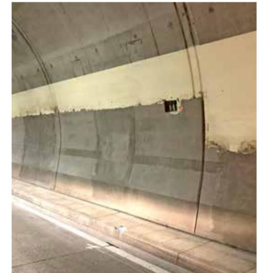
> Die im Tunnel bewährte Oberflächenbeschichtung Sikagard® WallCoat AT kam auf der vorbereiteten Altbeschichtung sowie auf den partiell instand gesetzten Bereichen zum Einsatz. Das geringer belastete Tunnelgewölbe, wurde mit der Hydrophobierung Sikagard®-705 L gegen eindringende Feuchtigkeit geschützt. Die lokal bedingten Brandschutzanforderungen im Murgwaldtunnel konnten durch den Einsatz des zementären Brandchutzspritzputz-Systemaufbaus SikaCem® Pyrocoat erfüllt werden. >
