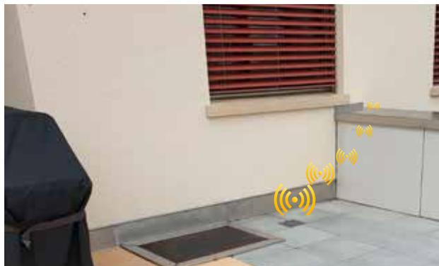
Anche nelle terrazze si può installare il sistema SikaRoof® SmartControl. In questa variante il sensore Active T è integrato in un nucleo isolante XPS e rimane nascosto all'interno della stratigrafia in modo sicuro senza disturbare l'estetica.
