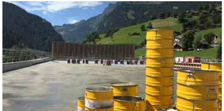
Das Parkhaus wurde mit einem Umkehrdach geplant, wobei hier Sikadur 188 und SikaBit EP5 für die Abdichtung eingesetzt wurden.
