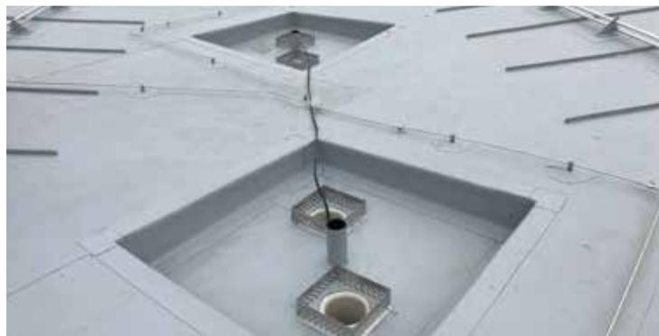
Die grossen Wasserabläufe wurden in der Mitte der Dächer platziert und das Gefälle so geplant, dass das Wasser über die homogene Fläche der Sika TPO-Abdichtung via diesen Abläufen abgeführt werden kann.
