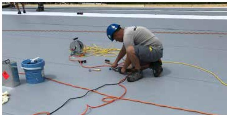
Der erfahrene Dach-Verleger Bauimplus AG, Heimberg konnte die praktischen, leicht ausrollbaren Sika-Abdichtungsbahnen innert kurzer Zeit thermisch verschweissen.
