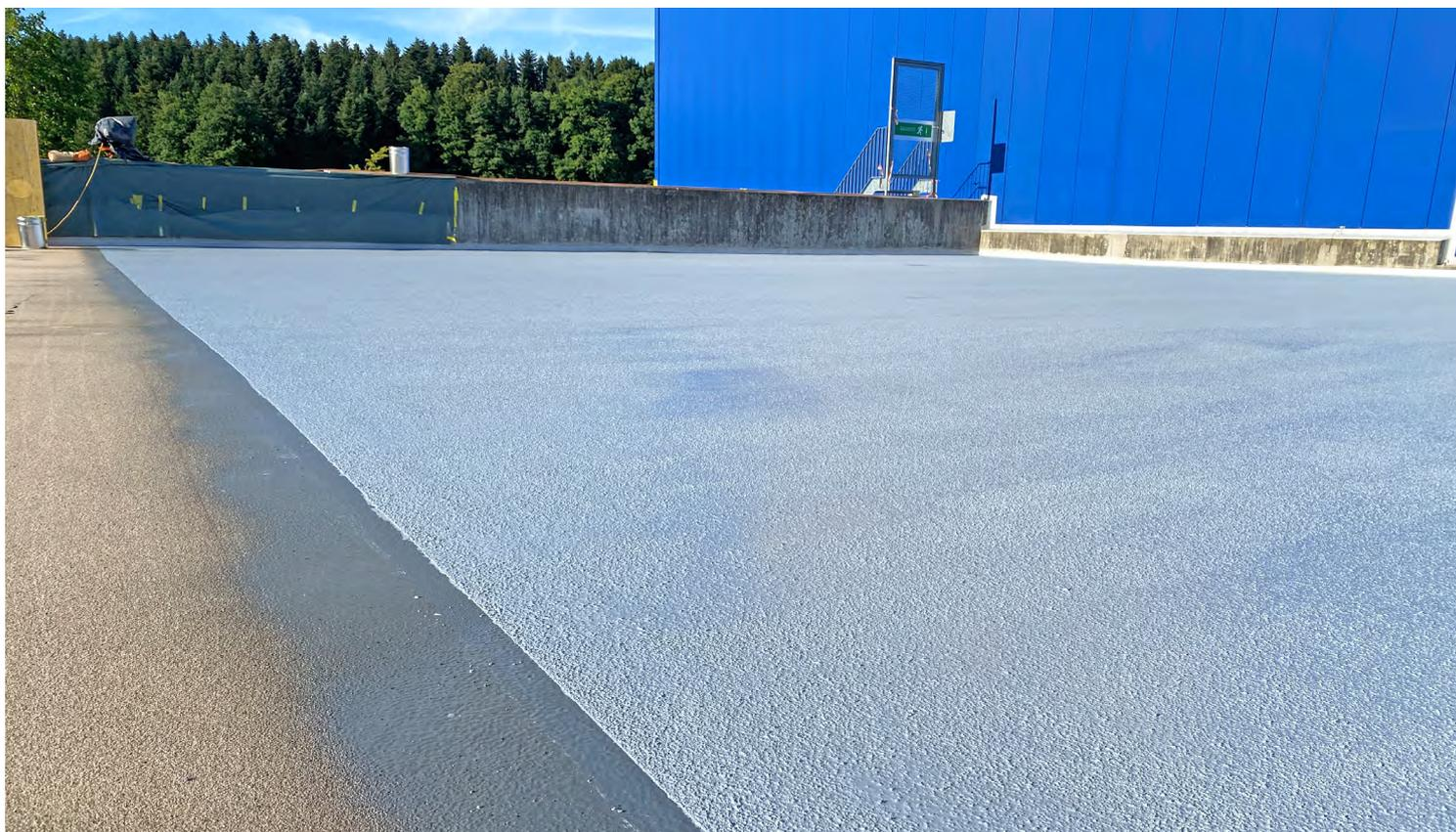
a également été utilisé comme pont d'adhérence pour le mortier de réparation et de reprofilage R4 Sika MonoTop®-452 N appliqué ultérieurement.
