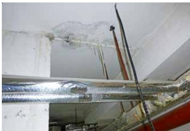
Kommunizierende Röhren führen ohne Kapillarsperre und Betonfugendichtband zu Feuchteschäden im Bereich der Beckenumgänge und der darunter liegenden Technikräume.
