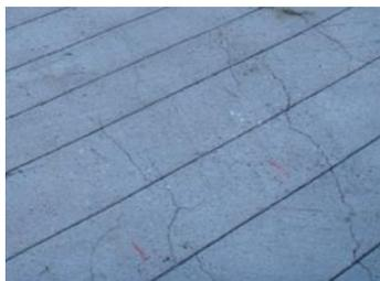
Contrairement à d'autres applications, l'installation des bandes pour rainures Sika® CarboDur® sur du béton légèrement endommagé ou fissuré (voir figure ci-contre) est possible et indépendante de la résistance à l'arrachement du béton.
