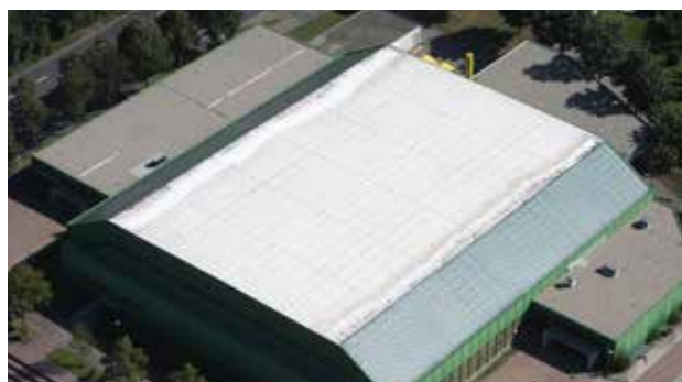
Grande salle Sursee avec Sarnafil TS 77
