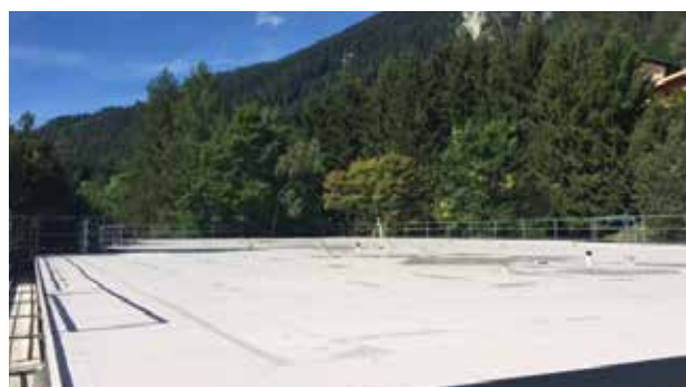
Piscine Fiesch avec Sarnafil TG 76 FSA
