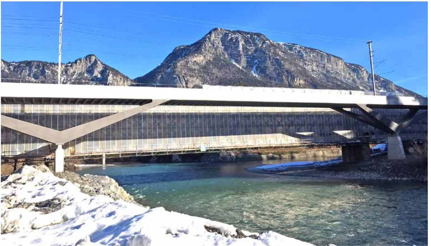
war stolze 74 Meter lang und 270 Tonnen schwer, wurde auf den vormontierten Brückenteil aufgesetzt, gut 70 Meter vorgeschoben und anschliessend etwa 2 Meter abgesenkt. Solche Bauvorgänge sind im Brückenbau nichts Ungewöhnliches. Bei diesem Objekt wurde der Vershub durch die gekrümmte Brückengeometrie, die Aufrechterhaltung des Verkehrs auf der A13 sowie die Grösse des zu verschiebenden Elementes massgeblich erschwert.
