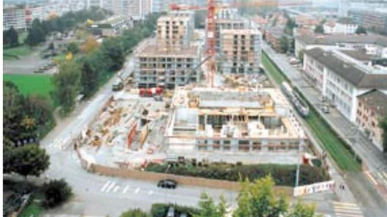
Das Permaton Abdichtungssystem mit Sika Produkten «Weisse Wanne» ist eine Systemleistung von der Planung bis zur Fertigstellung von wasserundurchlässigen Betonbauwerken mit zehn Jahren Garantie auf die Dichtigkeit. Das Abdichtungskonzept basiert auf wasserdichtem Beton, geeigneten Fugenabdichtungssystemen und Abdichtungslösungen für Details. Das Abdichtungskonzept kam bei allen Untergeschossen und im Bereich der Decke des Parkgeschosses zum Einsatz.
