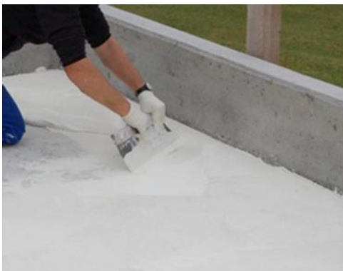
Abb. 4: Aufbringen des Klebstoffs mit einer Zahntraufel
