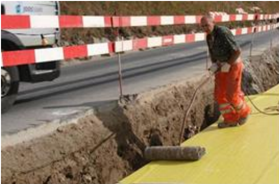
Abb. 7: Anpressen der Sikaplan® WP 2110 mit Anpressrolle
