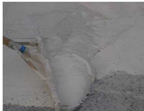
Abb. 5: Aufbringen des Klebstoffs mit einer Zahnrakel
