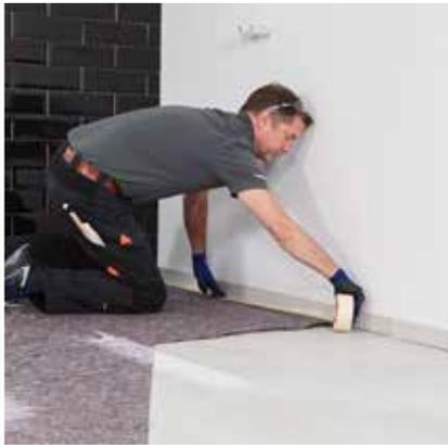
Recouvrir le carrelage avec un matériau de couverture approprié, par exemple un feutre de couverture
