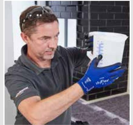
Mesurer la quantité d’eau nécessaire. Mélanger le récipient de 5.0 kg avec env. 1.4 l – 1.45 l d’eau.
