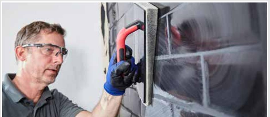
Une fois que le joint est en place, déterminer le moment du lavage au moyen du test de pression des doigts. Ce n’est que lorsque le mortier de jointoiment dans le joint a suffisamment pris que le revêtement peut être lavé.
