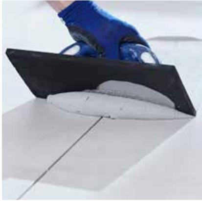
Appliquer le matériau dans le joint à l'aide d'une spatule de jointoiment.
