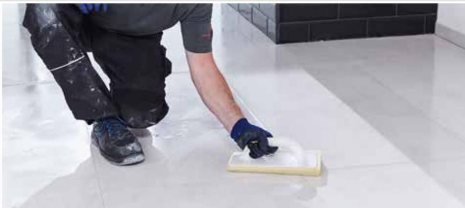
S'il reste de légers voiles de coulis après le lavage, ils peuvent être enlevés avec un peu d'eau propre, une spatule éponge ou même un chiffon en microfibre. Cela permet d'éviter un excès d'eau sur les joints.
