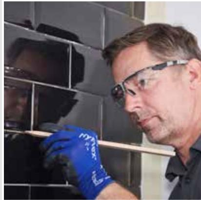
Gratter l’excès de colle carrelage des joints avant le jointoiment.
