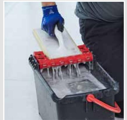
L'utilisation d'un seau de lavage facilite le nettoyage de la spatule éponge et donc le nettoyage de la surface.
