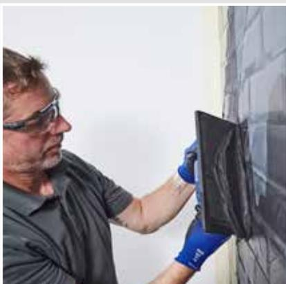
Appliquer la masse de jointoiment à l’aide d’une spatule de jointoiment. La consistance doit être adaptée au domaine d’application.
