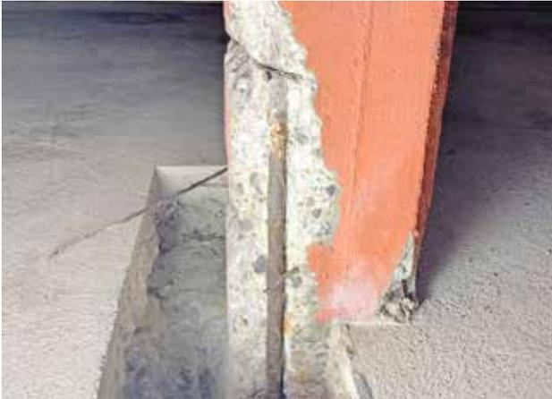
Sika Mono-Top®-412 Eco a été utilisé pour reprofiler les colonnes et répondre aux exigences de résistance au feu. Un enduit de ragréage fin Sika MonoTop®-723 Eco, afin de soigner l'esthétique, a été appliqué. Dans la zone des pieds de colonnes, une protection permanente contre la corrosion et les chocs a été réalisée au moyen d'un tissu de verre enrobé de résine époxy recouvert du système de protection contre la corrosion Sika® Permacor®-3326 EG H.
