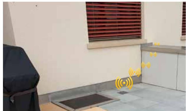
Les terrasses peuvent également être équipées d'un système SikaRoof® SmartControl. Avec ces variantes, le capteur Active T est intégré dans un noyau d'isolation XPS et "caché" de manière sûre et presque invisible une fois la structure terminée.
