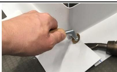
Fissare le sovrapposizioni orizzontali e saldarle con fon ad aria calda e rullino.
