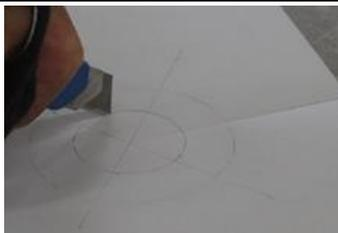
Intagliare un foro con un diametro di ca. 20-30 mm inferiore al diametro del tubo.
