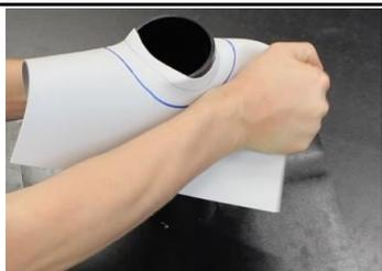
Infilare il lembo di nastro riscaldato sul tubo come un «mantello».
