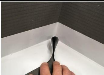
Posare il nastro senza pieghe nell'angolo interno e formare un'increspatura.
