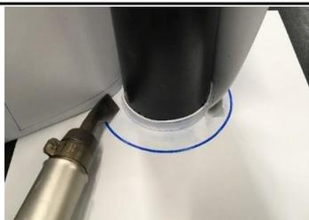
Scaldare la zona inferiore di sovrapposizione della «manica» e fissarla puntualmente sopra il «colletto». Poi saldare puntualmente la «manica» al piano orizzontale.
