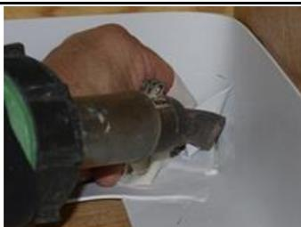
Fissare il cono punto dopo punto, saldandolo con fon ad aria calda e rullino.
