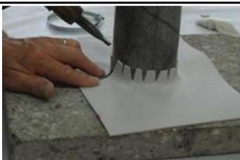
Scaldare il nastro con il fon ad aria calda e modellarlo attorno al tubo.
