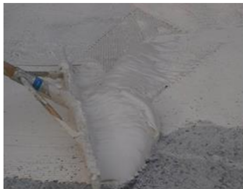
Fig. 5 Applicazione dell'adesivo con racla dentata.
