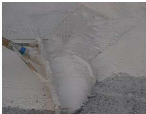
Fig. 5 Applicazione dell'adesivo con racla dentata.
