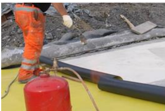
Fig. 6 Passaggio alla fiamma e applicazione del manto Sikaplan® WP 2110.
