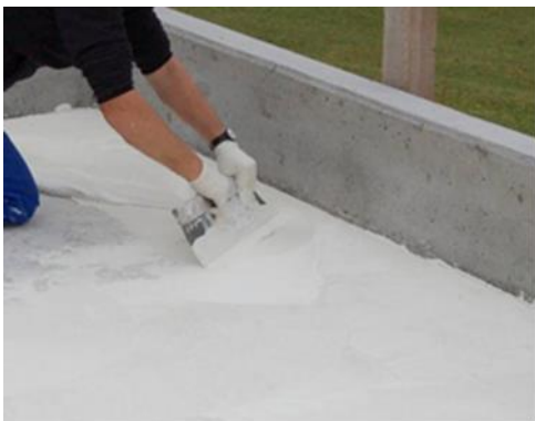
Fig. 4 Applicazione dell'adesivo con frattone dentato.
