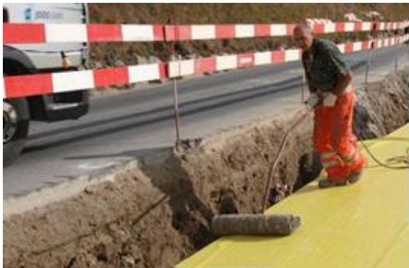
Fig. 7 Pressatura di Sikaplan® WP 2110 con rullo compressore.
