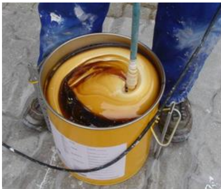
Fig. 3 Miscelazione di SikaForce®-420 L105
