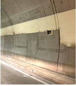
> contre la pénétration de l'humidité par un traitement hydrophobe Sikagard®-705 L. Les exigences locales en matière de protection contre les incendies dans le tunnel de Murgwald ont pu être remplies grâce à l'utilisation du système de protection ignifuge SikaCem® Pyrocoat à base de ciment, vermiculite et perlite.
