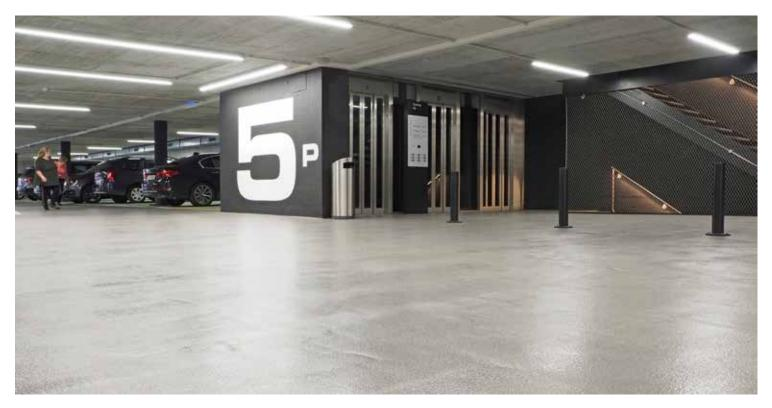
> poudrage dur Alox a été injecté directement. Pour le scellement final, Sikalastic®-8450 coloré et à durcissement rapide a été appliquée. Divers détails ont été réalisés avec le système d'étanchéité Sikadur-Combiflex® SG, les renforcements en PRFCSika® CarboDur® et le mortier de scellement expansif SikaGrout®. >
