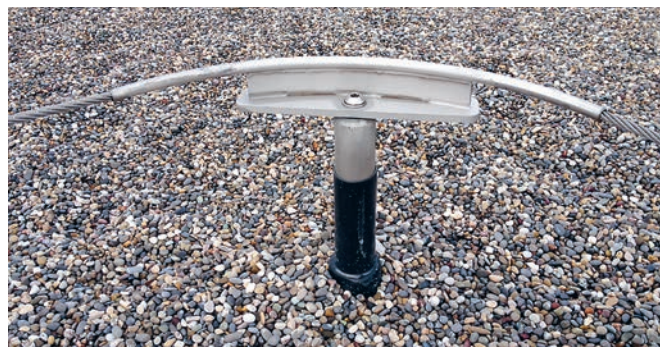
Abb. 6: Frei überfahrbarer Eckpunkt
