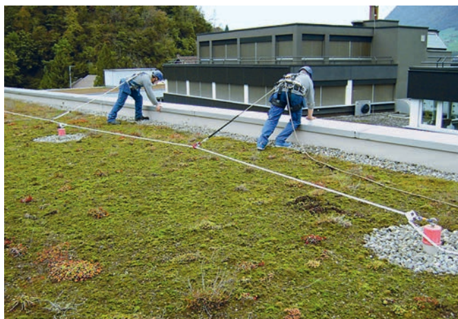
Abb. 10: Temporäres Seilsystem mit Karabinerhaken an EAP befestigt
