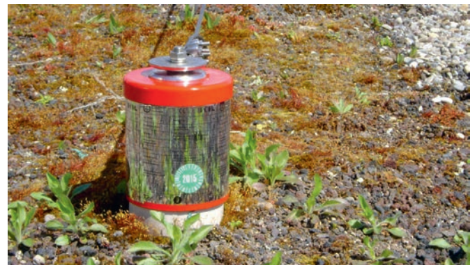
Abb. 25: Objektspezifische Anlagebeschriftung mit Prüfvignette
