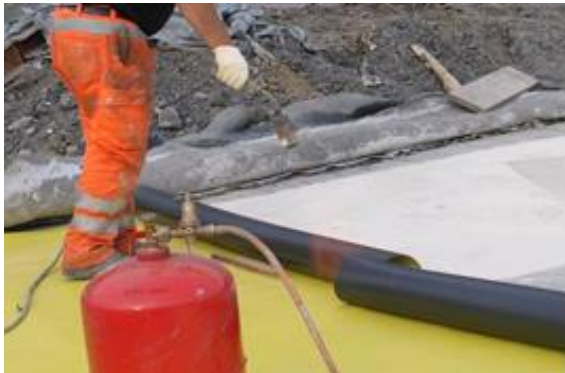
Fig. 6: Flammage et déroulement de Sikaplan® WP 2110
