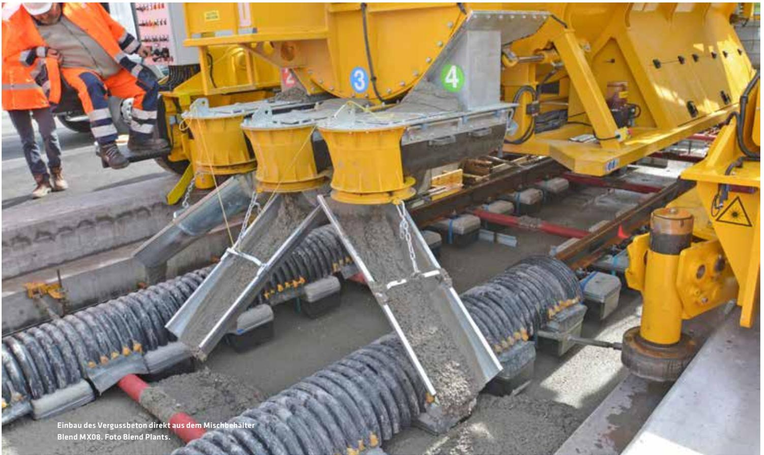
Einbau des Vergussbeton direkt aus dem Mischbehälter Blend MX08. Foto Blend Plants.
