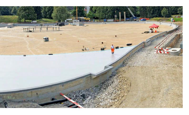
non-nageurs. Le soudage thermique entre les différents lés d'étanchéité en matière synthétique a été réalisé au niveau des surfaces horizontales à l'aide de soudeuses automatiques. Les détails et les petites soudures ont été réalisés par l'équipe à l'aide d'un foehn à air chaud. Les soudures ont ensuite été scellées à l'aide d'une pâte. Ainsi, les raccords font l'objet d'un contrôle visuel supplémentaire.
