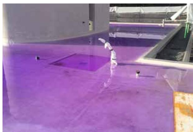
Durch den realisierten Wasserstand auf der Abdichtung über mehrere Tage kann die Dichtigkeit über das Kontrollrohr vor der Abnahme der Flachbedachung einfach und sicher geprüft und protokolliert werden.
