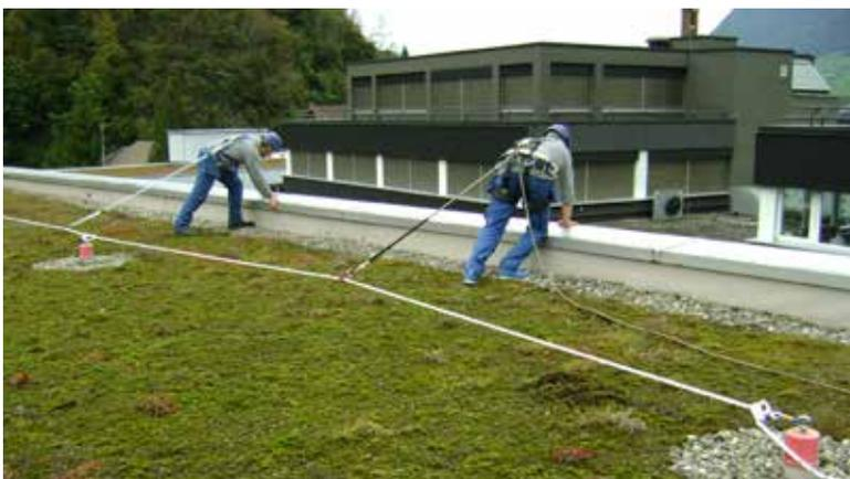
Die Sika bietet sowohl für Einzelanschlagpunkte wie auch für permanente Seilsicherungen das passende Sortiment an. Verschiedene, auf die Unterkonstruktion abgestimmte und geprüfte Bauarten ermöglichen eine fachgerechte Befestigung. Mit den Dichtsets können die Stützen einfach und sicher an die Abdichtung angeschlossen werden.
