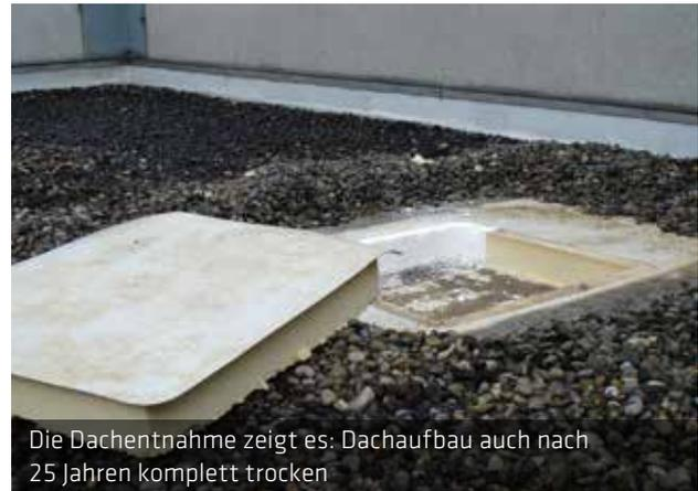
Die Dachentnahme zeigt es: Dachaufbau auch nach 25 Jahren komplett trocken
