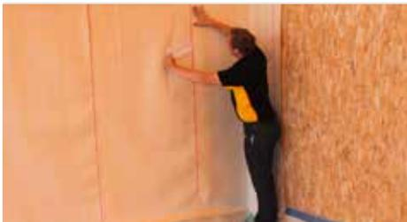
4. Die Schutzfolie des Selbstklebestreifens entfernen und die Überlappung verkleben.
