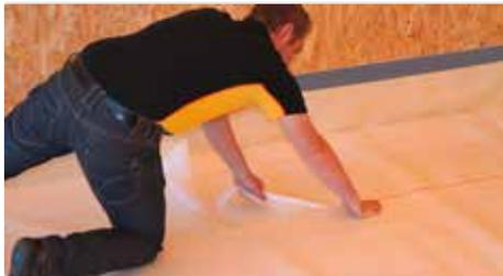
4. Schutzfolie auf dem Selbstklebestreifen entfernen und die Bahnen verkleben.
