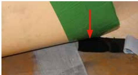
7. Das untere Tape aussen auf die angehobene Abdichtungsbahn kleben.
