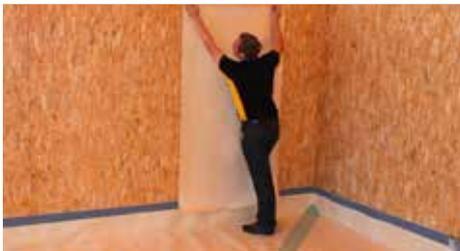
1. Erste Bahn senkrecht befestigen (davor mit Wasserwaage eine senkrechte Linie aufzeichnen).
