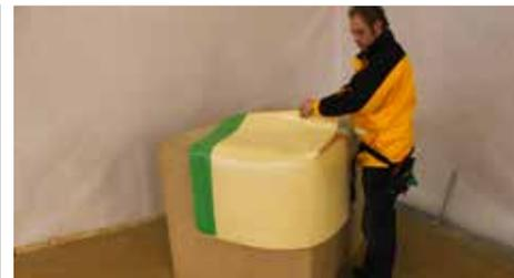
2. Die Abdichtungsbahn umdrehen und auf den Holzkasten legen, so dass die Vliesseite unten ist.
