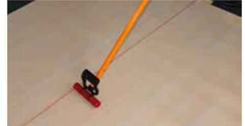
Für eine optimale Haftung die Überlappung mit dem Anpressroller andrücken.
