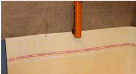
Grundsätzlich ist die Abdichtungsbahn so wenig wie möglich zu befestigen, damit beim Ausschalen eine möglichst geringe Schälwirkung entsteht. Es gibt verschiedene Möglichkeiten die SikaProof® A an vertikalen Untergründen zu befestigen:
