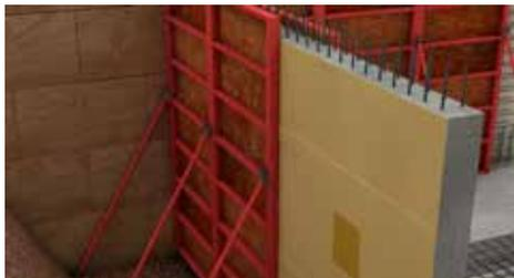
Bei zweihäufigt geschalteten Wänden, müssen sämtliche Bindstellen nach dem Ausschalen abdichtet werden.
