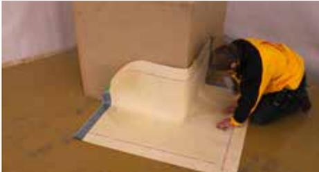
11. Passstück positionieren und auf dem aufgeklebten SikaProof® ExTape-150 verkleben.
