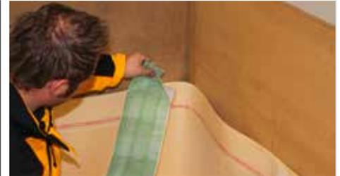
8. SikaProof® Tape-150 am Ende 50 mm einschneiden und leicht überlappen
