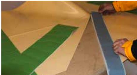
Tipp: SikaProof® ExTape-150 falten und mittig über die Schneidkante kleben. Schutzfolie nur auf einer Seite entfernen.
