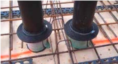
Zusätzlich zur SikaProof® A Aufbordung von 150 mm sind Rohrdurchdringungen mit Dichtungsmanschetten/Mauerkrägen abzudichten.
