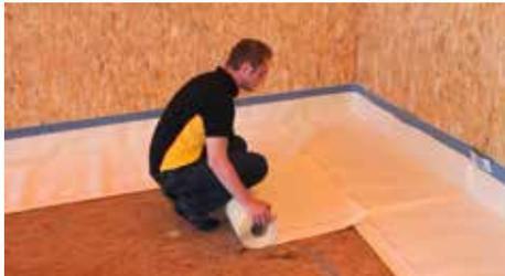
1. In der Ecke beginnen und mit dem bereits ausgeführten Boden / Wandanschluss verbinden.
