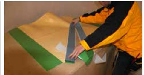
3. SikaProof® ExTape-150 zuschneiden, auf beiden Schneidkanten aufkleben (mind. 50 mm überlappen).
