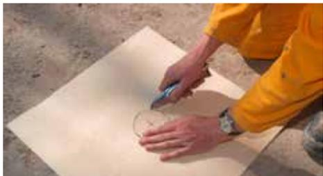
4. Passstück vorbereiten. Mind. 50 mm Überlappung auf beiden Seiten. Loch  $\varnothing$  30 – 40 mm kleiner ausschneiden als Aussenrohrdurchmesser.
