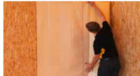
2. Nächste Bahn so überlappen, dass das Bahnenende zwischen den beiden roten Markierungslinien endet.
