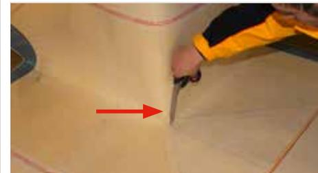
10. Die Spitze des Passstückes, welches zur Ecke zeigt, leicht einschneiden ca. 20 mm.
