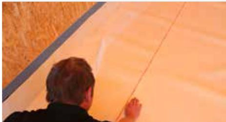
3. Abdichtungsbahn zwischen den zwei roten Markierungslinien ausrichten.
