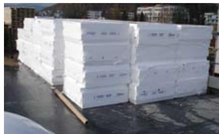
Auf die Bauzeitabdichtung wurden S-Therm Wärmedämmplatten verlegt.
