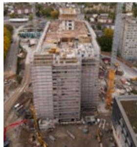
recyclage ainsi que l'ingénierie et la mise en œuvre sur le chantier par Vistona ont permis la réalisation d'une construction en béton de recyclage étanche à l'eau en y intégrant un étanchement des joints des plus modernes. La «cuve blanche» requiert environ 4000 m<sup>3</sup>
