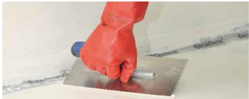
Applicare l'impermeabilizzazione in poliuretano Schönox® EA PUR 5 con una talocchia a dentatura 6.
