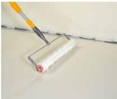
Passare rullo frangibolle (lunghezza aghi ca. 1 cm) sull'impermeabilizzazione e controllare lo spessore dello strato.
