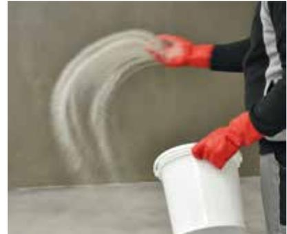
Cospargere la superficie impermeabilizzata con Sika® sabbia di quarzo 0.3 - 0.9 mm.
