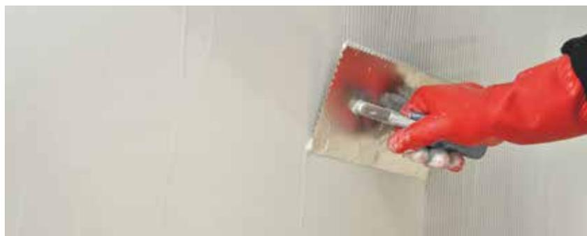
Lisciare anche il secondo strato di Schönox® EA PUR S con una talocchia e controllare lo spessore dello strato.
