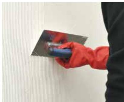
Applicare l'impermeabilizzazione in poliuretano Schönox® EA PUR S con talocchia liscia o dentata (p.es. 4 mm)
