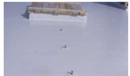
*Die Blitzschutzdrahthalter sind direkt auf die Dachhaut aufgeschweisst.*
