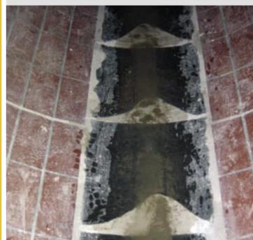
Gravi fenomeni di erosione e abrasione sul fondo
