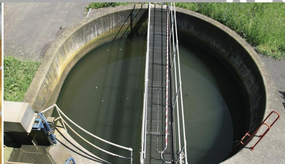
Dissabbiatore: carico dovuto ad abrasioni ed erosioni
