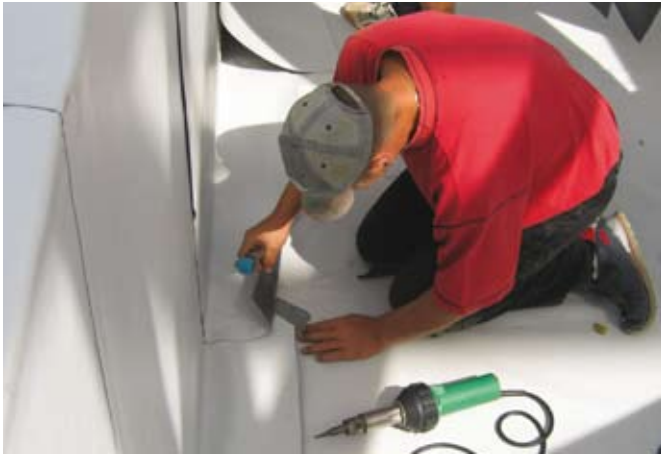
Exaktes Arbeiten vor allem bei den Details war Voraussetzung.
