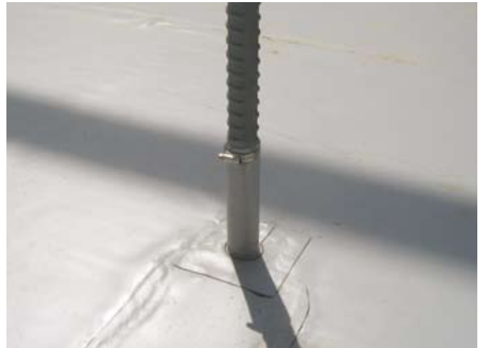
Durchdringung eines Zugseiles: spezielle Einfassung für absolute Dichtigkeit wurde erstellt.
