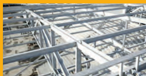
PROTECTION ANTICORROSION ET PROTECTION IGNIFUGE
