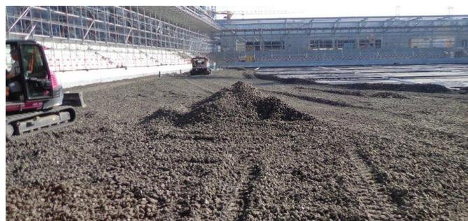
Auf die durchschlagsichere Sarnafil-Schutzlage kam eine 80 cm dicke Drainage, worauf zum Schluss der Rasen verlegt wurde.
