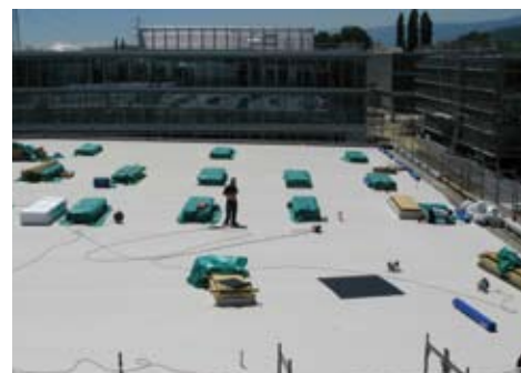
La partie dépôt de 2'160 m 2 a été étanchée rapidement avec le lé d'étanchéité écologique Sarnafil.
