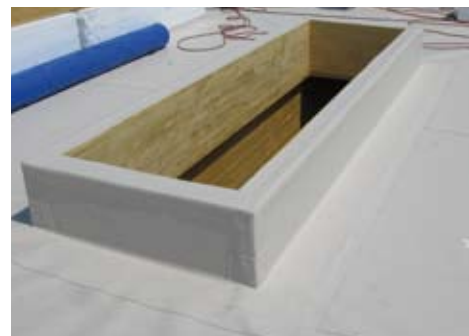
Les nombreux détails des puits de lumière ont été exécutés aisément.
