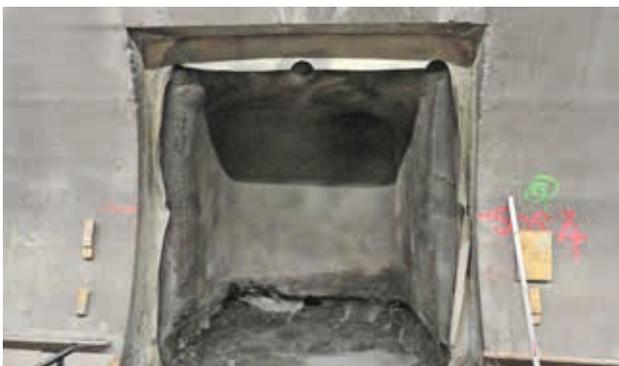
Eine ausgegrabene Nische ermöglicht den Zugang während der Wartungsarbeiten zu den 44 Jahre alten, eingebauten Sika Kunststoff-Dichtungsbahnen.
