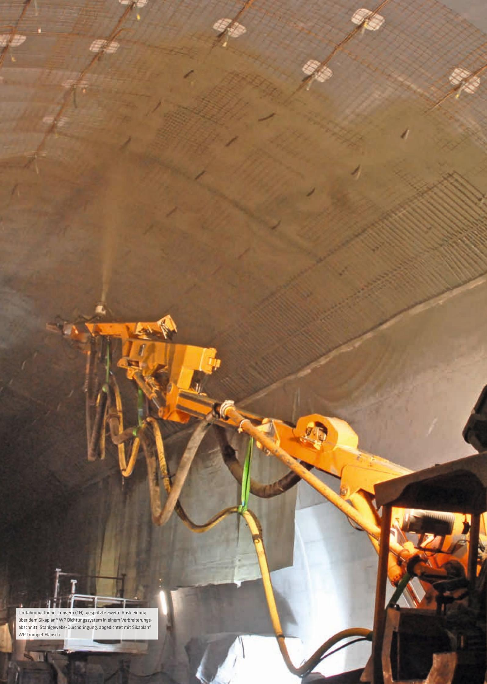
Umfahrungstunnel Lungern (CH), gespritzte zweite Auskleidung über dem Sikaplan® WP Dichtungssystem in einem Verbreiterungsabschnitt, Stahlgewebe-Durchdringung, abgedichtet mit Sikaplan® WP Trumpet Flansch.
