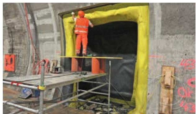
Anschlussarbeiten einer neuen Kunststoff-Dichtungsbahn auf eine bereits über 40 Jahre eingebaute Membrane. Die beiden Dichtungsbahnen können thermisch verschweisst werden.
