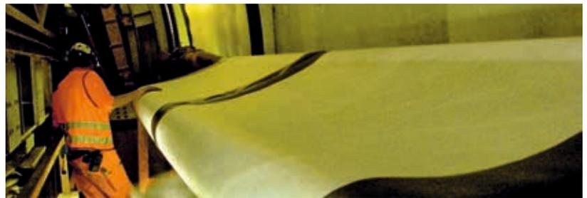
**VLIESKASCHIERTE KUNSTSTOFF-DICHTUNGSBAHNEN** können durch aufkleben mit Hotmelt Klebesystemen auf ebene Untergründe wie beispielsweise Tübbinge vollautomatisch streifenweise aufgeklebt werden.
