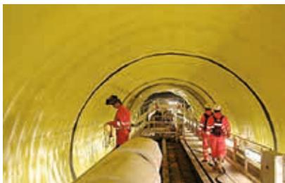
Nach dem Schweißen müssen alle Nähte auf gute Verarbeitung sichtgeprüft werden. Besondere Aufmerksamkeit gilt dabei den T-Verbindungen, Durchdringungen und Anschlüssen.
