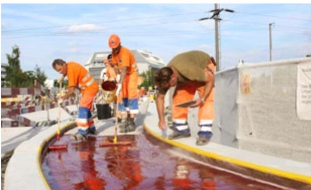
■ Sika Ergodur-500 SB è una sigillatura a base di resina epossidica fortemente accelerata, collaudata e omologata secondo ZTV-ING Allegato 7 e adempiente i requisiti della norma SN 640 450a.
