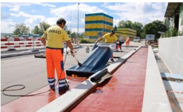
■ La fiammatura del PDB è possibile già dopo sole 8 ore\*. Se non è possibile la messa al coperto, Sika Ergodur-500 SB può essere definito resistente alla pioggia già dopo poche ore\*.
