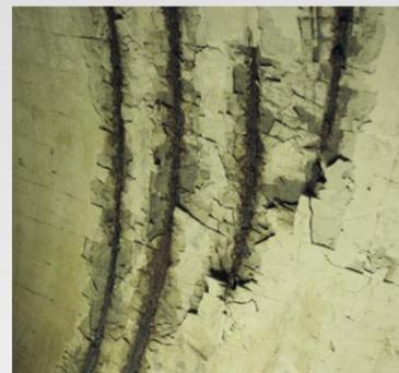
Starke Betonschäden an den Seitenwänden
