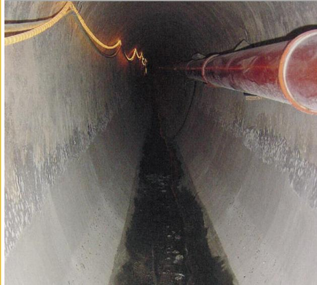
Belastungszone B: Häufig sind Betonschäden in diesem Bereich vorhanden.
