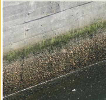
Starke Betonschäden und Auswaschungen
