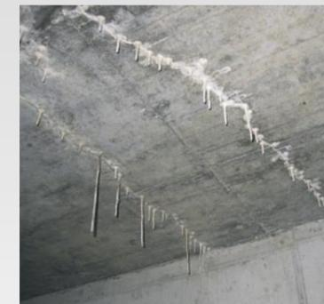
Undichtigkeiten an der Deckenuntersicht
