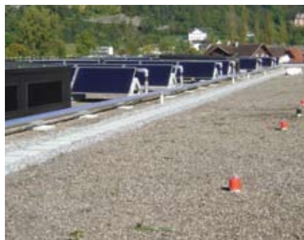
Ein Teil der Dächer wurde begrünt. Dabei kam auch die Sicherheit auf dem Dach nicht zu kurz: Mit der Seculine Vario Absturzsicherung.
