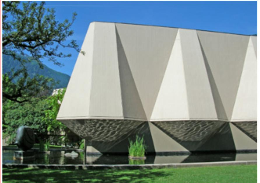
des façades sur lesquels la structure du coffrage en lames de bois a volontairement été exprimée ont souffert du temps et présentaient une assez forte dégradation du béton.
