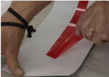
1. Rimuovere la striscia mediana rossa del nastro Sikadur-Combiflex® SG tipo M. In questo modo si evitano difetti di saldatura.
