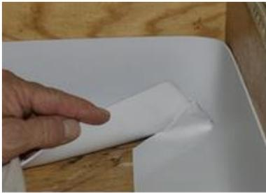
8. Evitare inclusioni d'aria e punti non saldati.
