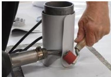
11. Fissare puntualmente la zona di sovrapposizione del «mantello», quindi procedendo dal basso verso l'alto eseguire dapprima una presaldatura, poi una saldatura definitiva.
