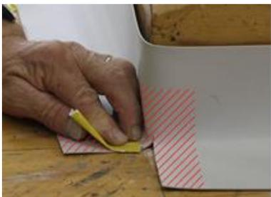
8. Irruvidire con carta abrasiva o Scotch Brite la zona di nastro da saldare attorno allo spigolo.
