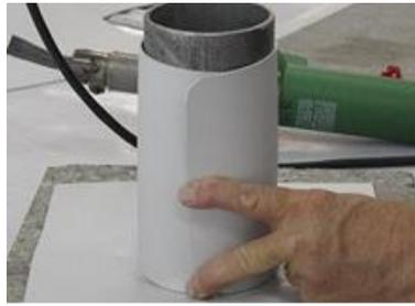
5. Tagliare una porzione di nastro larga ca. 15 cm e di lunghezza sufficiente ad avvolgere completamente il tubo («mantello»), calcolando una zona di sovrapposizione di ca. 30 mm.
