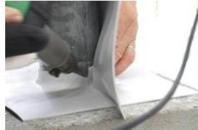
9. Saldare il «mantello» nella zona di sovrapposizione con il fon ad aria calda ed esercitando pressione.
