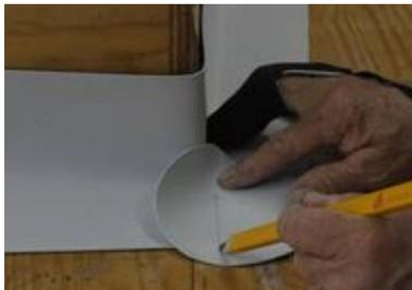
6. Appoggiare il disco in corrispondenza dello spigolo e disegnare le superfici da saldare.
