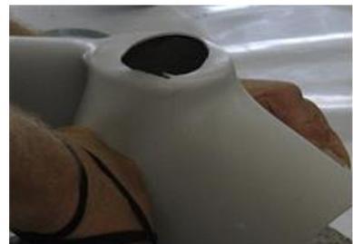
3. Scaldare e modellare il nastro fino a quando sarà possibile infilarlo sul tubo come una «gonnella».
