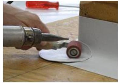
13. Fissare le sovrapposizioni orizzontali e saldarle con fon ad aria calda e rullino.
