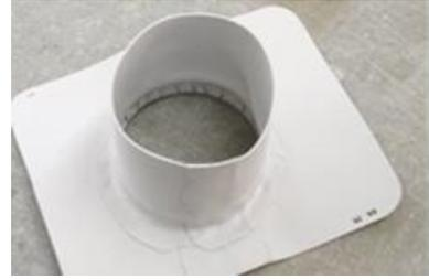
4. Scaldare il nastro con il fon ad aria calda e modellarlo attorno al tubo.
