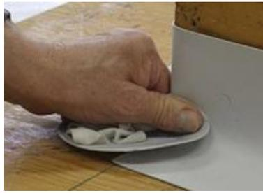
12. Saldare al nastro il lobo verticale del disco, lungo lo spigolo, procedendo dal basso verso l'alto, e premere con le dita. Saldare e premere anche i lati del lobo verticale.
