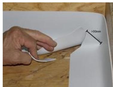
1. Rimuovere la striscia mediana rossa del nastro Sikadur-Combiflex® SG tipo M. In questo modo si evitano difetti di saldatura.
