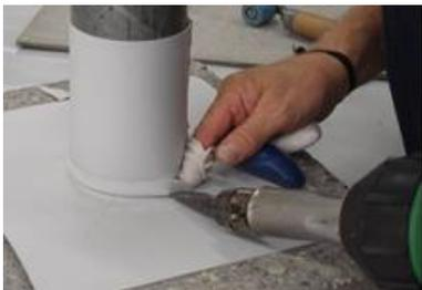
10. Premendo con un dito, eseguire una presaldatura del colletto del «mantello» e saldare definitivamente con il rullino.
