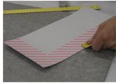
6. Irruvidire con carta abrasiva o Scotch Brite le zone del «mantello» da saldare.
