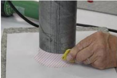
7. Irruvidire anche la cintura di nastro sopraelevato della «gonnella» da saldare.
