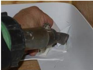
18. Fissare il cono punto dopo punto, saldandolo con fon ad aria calda e rullino.
