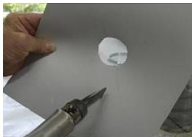
2. Nella zona del foro scaldare il nastro Sikadur-Combiflex® SG con il fon ad aria calda.
