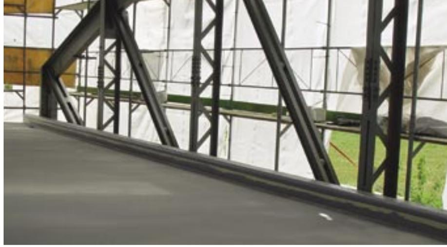
Bei der historischen Reussbrücke Rottenschwil handelt es sich um eine fast 100 Jahre alte Stahlkonstruktion, die saniert werden musste. Um die Nutzlast der Brücke beizubehalten, wurde das Eigengewicht reduziert. Dies wurde bewerkstelligt, indem man die Betonplatte der Fahrbahn durch eine Stahlplatte ersetzte. Auf dieser Stahlplatte kam **Icosit® Elastomastic TF** als Korrosionsschutz und Verschleisschicht zur Anwendung.
