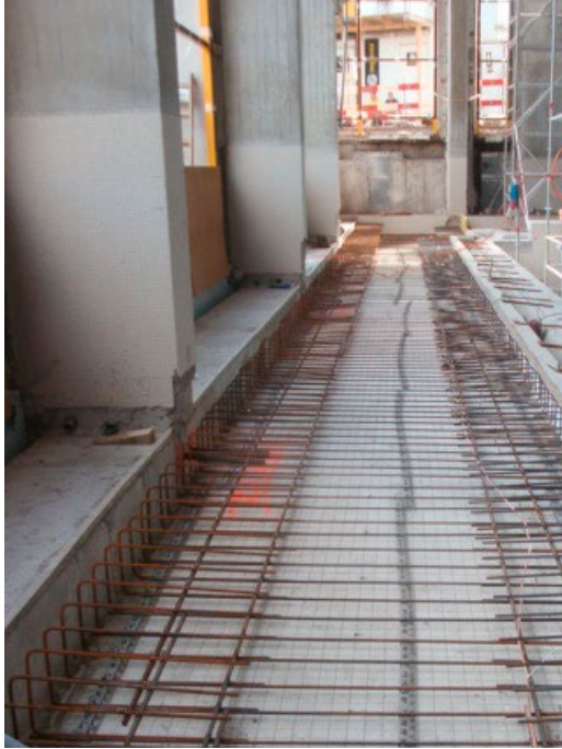
Bewehrungsarbeiten am neuen Beckenumgang
