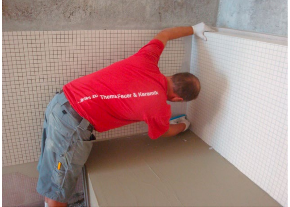
Verfugung Steinzeugmosaik mit SikaCeram EpoxyGrout
