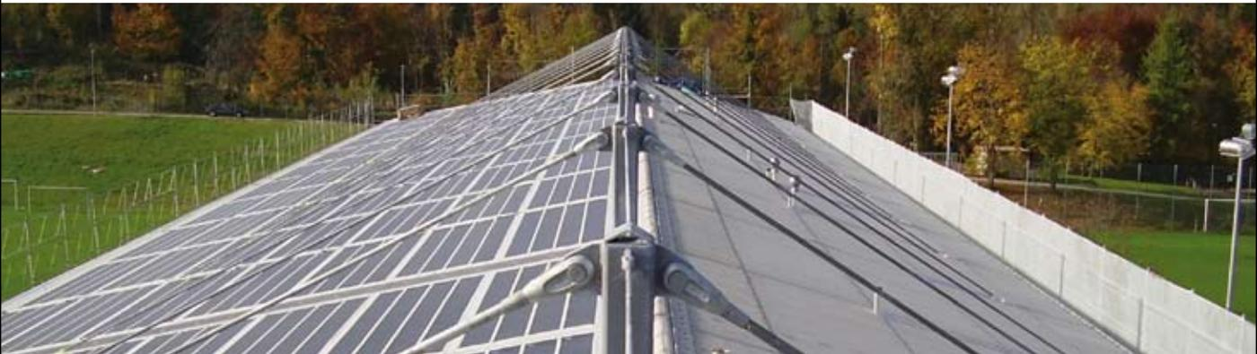
Die Photovoltaik-Anlage, die man auf dem Tribünendach geplant hatte, musste einige Rahmenbedingungen erfüllen: Die Anlage durfte die statische Belastung der angestrebten Pylonen-Lösung nur unwesentlich belasten. Zudem musste sie sowohl architektonisch wie auch ästhetisch in das Schrägdach integriert werden. Weiter sollten die Stromerträge der Anlage trotz des Schattenwurfes der darüberliegenden Stahlkonstruktion und trotz diffusem Licht möglichst hoch sein.
