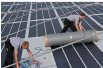
Ausrollen und platzieren der PV-Module...
