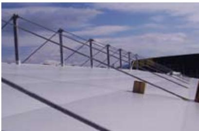
Mit Sarnafil abgedichtetes Dach bereit für die nachfolgende Montage der PV-Module.
