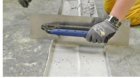
Mittige Position des Stopfprofils in direktem Kontakt mit dem Abdeckband (Trennlage) auf der Unterseite der Bodenpaneele.
