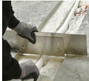
Höhenjustierung des Randdämmstreifens mittels einstellbarer Traufel.
