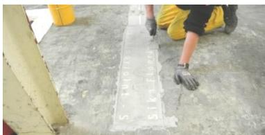
Mittels eines Spachtels werden die Kanten anschliessend mit dem Sikadur® Systemkleber verspachtelt.
