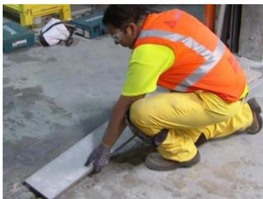
Platzierung der Fugenpaneele in der Fugenaussparung
