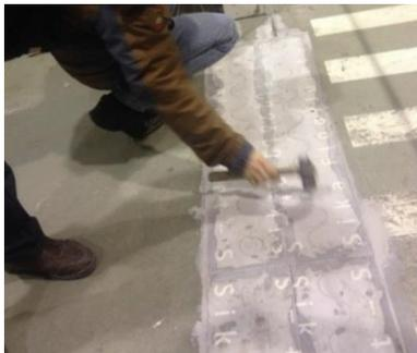
Zur Qualitätssicherung wird eine Prüfung auf Hohlstellenfreiheit mittels Abklopfen der Fugenpaneele empfohlen. Dies erfolgt am besten direkt nach der Verlegung oder aber nach dem Verfüllen der Kanten.
