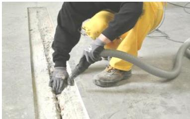
Staub, lose und schlecht haftende Teile müssen vor der Applikation des Sikadur® Systemklebers restlos entfernt werden, vorzugsweise mit einer Bürste und einem Industriestaubsauger.
