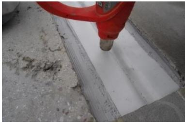
Die Anpassung des Sikadur-Combiflex® SG Bandes an den Fugenverlauf kann durch vorsichtiges Erwärmen mittels Heissföhn erfolgen.
