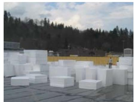
Auch in puncto Wärmedämmung hat man sich für die ökologische Variante mit EPS Wärmedämmung entschieden.
