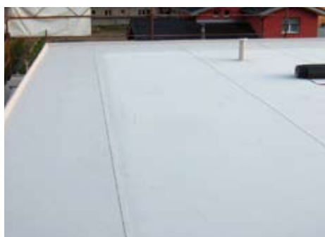
Le lé d'étanchéité Sarnafil TG 66-18 est soudé thermiquement.
