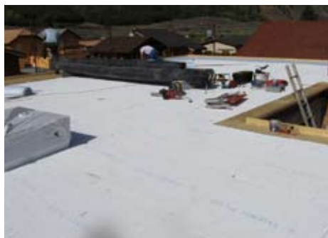
Comme isolant il a été choisi le S-Therm Plus, une isolation particulièrement bien adaptée pour les constructions minergie.
