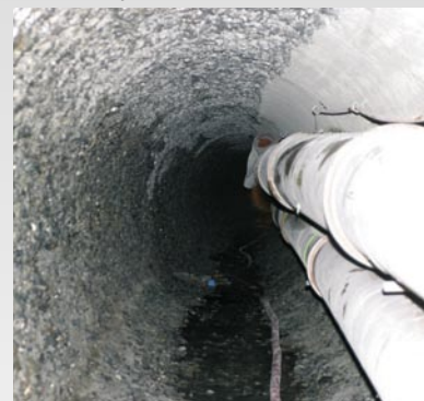
Support traité au jet pour un reprofilage en plein
