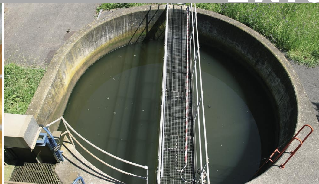
Dessableur: sollicitation par abrasions et érosions
