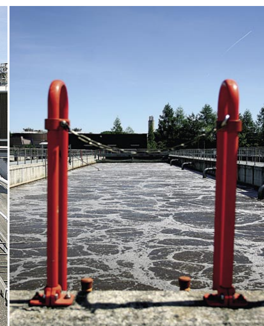
Bassin biologique: forte sollicitation dans la zone d'échange des eaux
