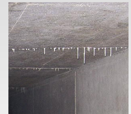
Surface de béton traitée avec un produit hydrofuge: protection du béton contre l'eau de condensation
