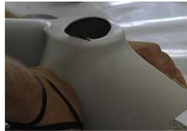
1. Découper un carré d'environ 30 x 30 cm dans une bande Sikadur-Combiflex® SG. Utiliser de préférence une bande d'une épaisseur de 2 mm. Découper un trou rond d'environ 20 mm plus petit que le diamètre du tuyau dans le morceau de bande.
