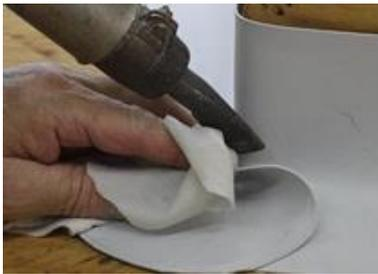
11. Fixer la rondelle ponctuellement à l'aide d'un föhn à air chaud.
