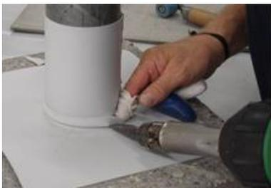
10. Présouder la collerette en comprimant avec les doigts sur la surface de raccordement puis soudage final au moyen du rouleau de compression.
