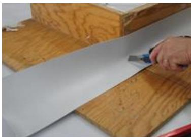
3. Entailler la bande à angle droit jusqu'à environ 5 mm de l'arête.
