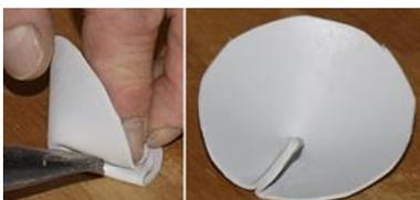
14. Chauffer le pli extérieur au moyen d'un föhn à air chaud, compresser à la main et souder.
