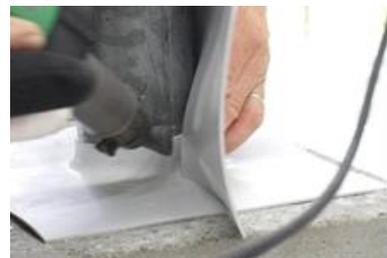
7. Poncer la surface de soudage de la bande de raccord.
