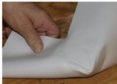
10. Les cordons de soudure peuvent être testés à l'aide d'un tournevis après refroidissement.
