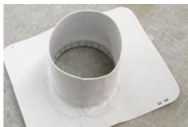
4. Chauffer la pièce au moyen d'un föhn à air chaud et former autour du tuyau.
