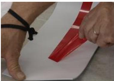
1. Retirer la bande centrale rouge de la bande Sikadur-Combiflex® SG type M. Ceci permet de prévenir les défauts de soudage.
