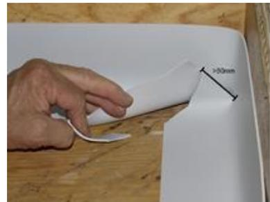
1. Retirer la bande centrale rouge de la bande Sikadur-Combiflex® SG type M. Ceci permet de prévenir les défauts de soudage.
