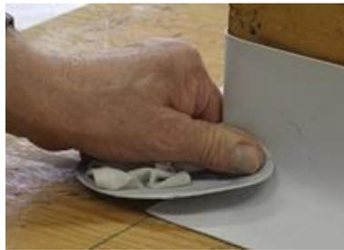
12. Souder la languette verticale vers l'angle de bas en haut sur la bande d'angle et compresser manuellement. Souder et compresser également les flancs de la languette verticale.
