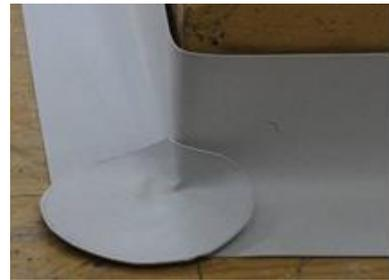
10. ... jusqu'à ce que la rondelle soit exactement adaptée à l'angle.
