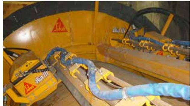
Spritzbetonsicherung hinter dem Ausbruch mit Nassspritzbeton im TBM-Vortrieb
