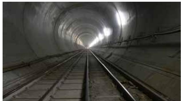
Innenringbeton als dauerhafter Endausbau der beiden Haupttunneln
