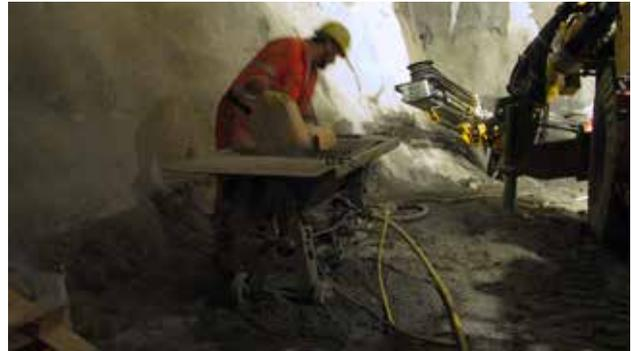
Temporäre Ausbruchsicherung mit Trockenspritzmörteln
